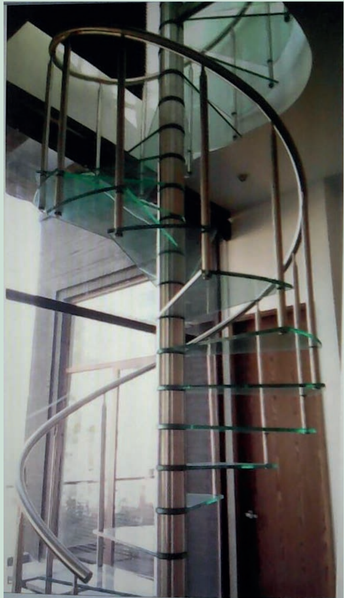
Escalera en vidrio multilaminado (20 mm) de seguridad con diseño antiresbalante y accesorios en acero inoxidable
